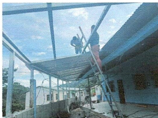
Foto 4: Instalacion de estructura de techo y cubierta de lamina calibre 26 de una caida de agua para patio.
