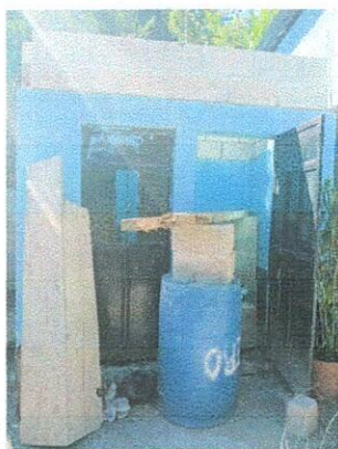
Foto 3: Mejoramiento de puertas de baños, cambio de estructura de techo y cubierta de lamina calibre 26. Ampliacion de pared de baño.
